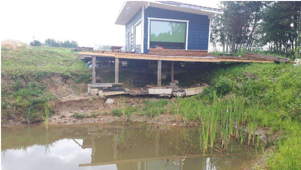
Foto 5. Tiigi lõunakaldal olev hoone. Hoone terrassi all on tuvastav nõlva deformatsioon. Drenaažisüsteemi nr 3 suue leidmata.
